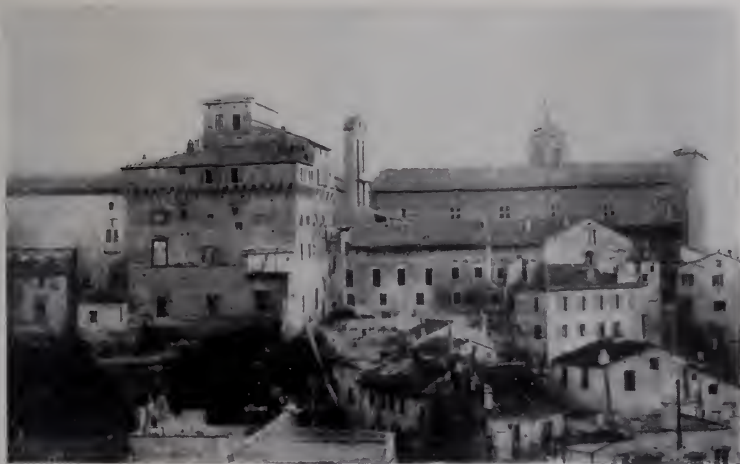
37. — Parte Nord del Colle Capitolino prima dei lavori.
